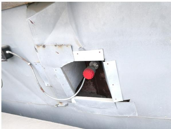
*Рис. 2 Высокотемпературный датчик в бункере электрофильтра*
