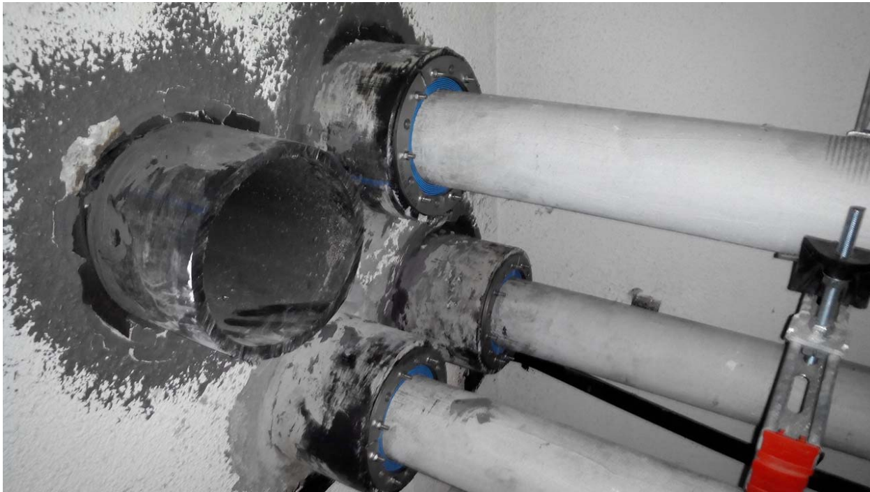
Рис. 3. Муфта Roxtec UG при уплотнении футляров для кабелей.
