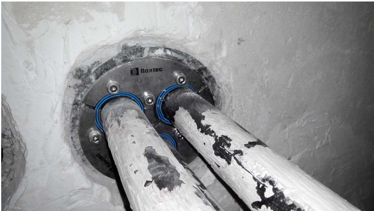
Рис. 4. Roxtec UG для ввода силовых кабелей.
