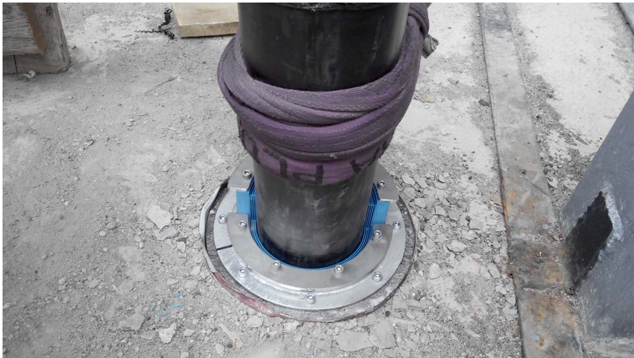
Рис. 5. Разборные конструкции гильз позволяют уплотнять уже проложенные кабели и трубы
