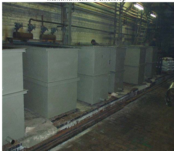
Гальванический цех защищенный ламинатами «Ремохлор»
