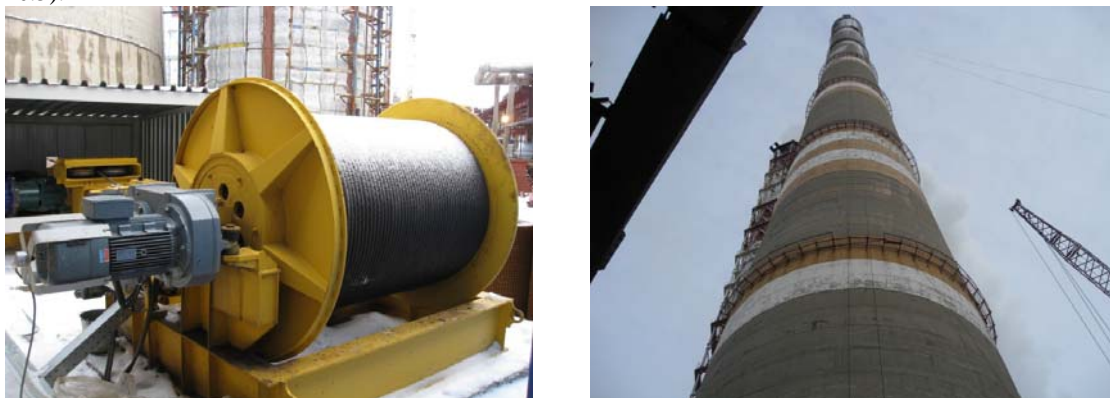
Рис. 5. Специальный подъемник для ремонта и реконструкции высотных дымовых труб, поставленный на Рязанскую (Новомичуринскую) ГРЭС
