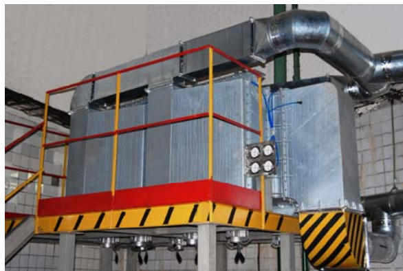
Рис.5. Адсорбер АТС-5000 конструкции НИИОГАЗ на КНС «Медведковская» АО «Мосводоканал».
