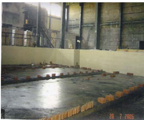
Поддоны под ванну травления, защищенные ламинатом «Ремохлор»
