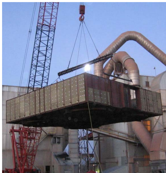
Рис.9. Установка камеры чистого газа
