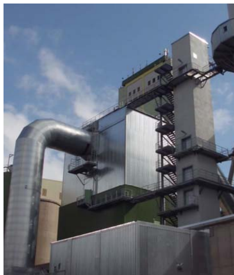
Рис.3. Двухпоточный фильтр GEA ECOpuls
