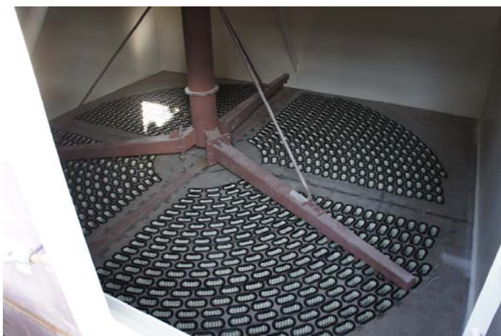
Рис.4. Камера очищенного газа с продувочным коллектором низкого давления
