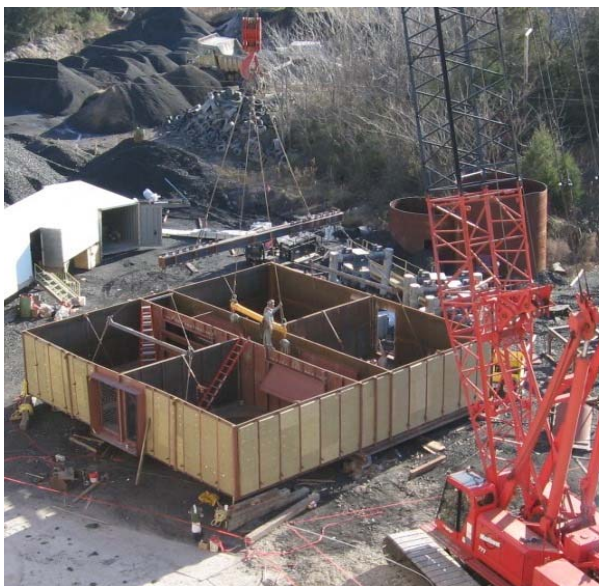
Рис.8. Сборка камеры чистого газа
