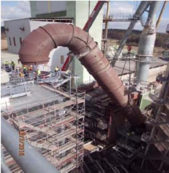
Рис.7. Монтаж газохода
