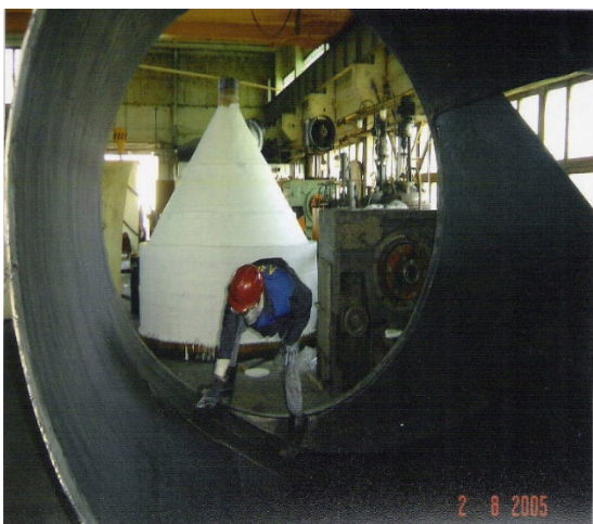
Защита полиэфирной трубы ламинатом «Ремохлор»
