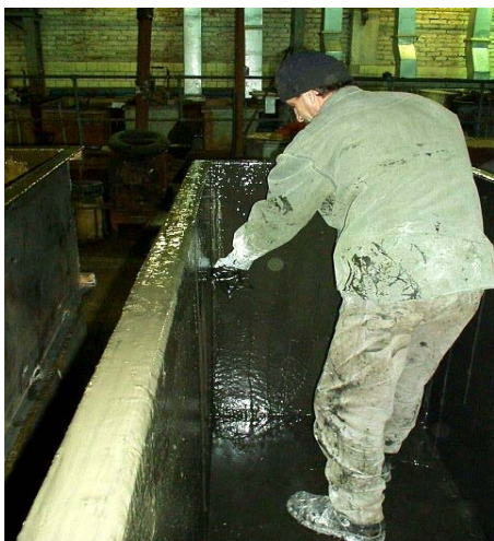
Защита гальванической ванны ламинатом «Ремохлор»
