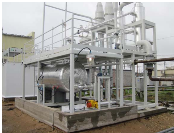
Рис.5. ККР 300, производительность 300 м 3 /час. Гатчина, компания ЗАО «ЛВЖ-701». Одновременная и независимая рекуперация паров прямогогонного бензина при больших и малых дыханиях резервуарного парка и при работе АСН в автоцистерны.
