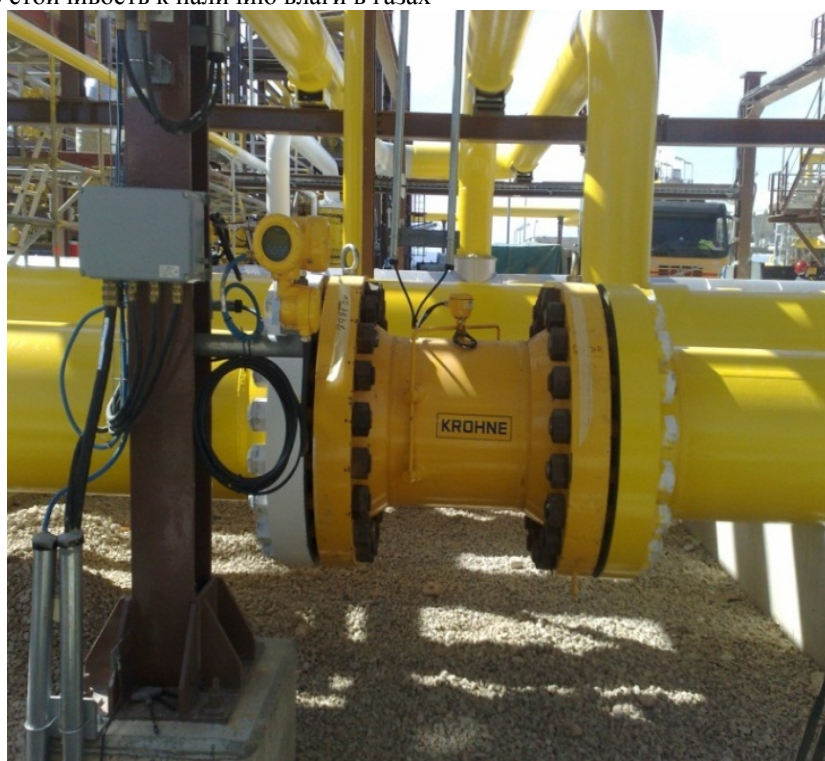
Рис.3 Измерение расхода природного газа на трубопроводе ДУ 600 мм с применением ультразвукового расходомера OPTISONIC 7300
