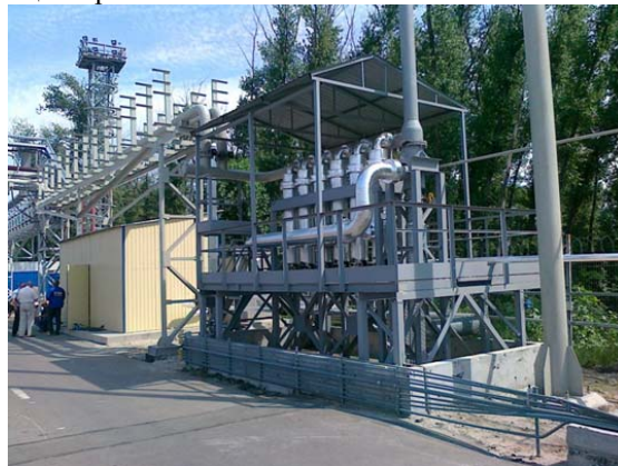
Рис.2. ККР 600, производительность 600 м 3 /час. Ростов-на-Дону, причальный комплекс, РФ НЗНП. Рекуперация паров прямогонного бензина при загрузке танкеров.
