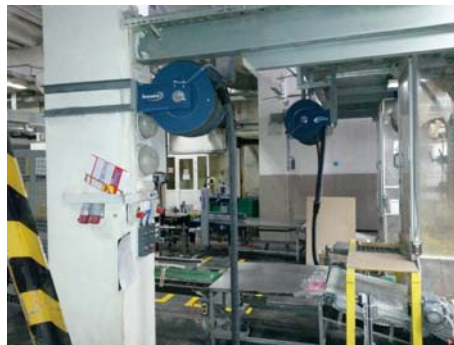
Рис. 5. Посты ручной пылеуборки с катушками для вакуумных шлангов.
