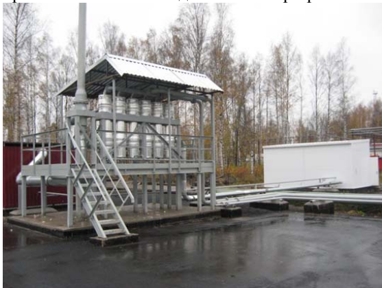
Рис.1. ККР 500, производительность 500 м 3 /час. Санкт-Петербург, нефтебаза «Ручьи», ПТК. АСН, работа в одной установке с двумя паровоздушными потоками различного состава.
