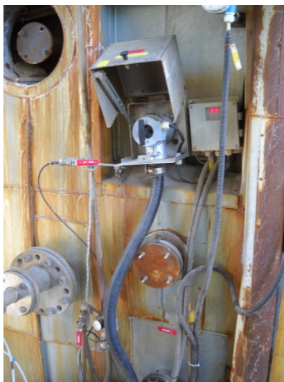
Рис. 3. Пробоотборный зонд и обогреваемая линия.
