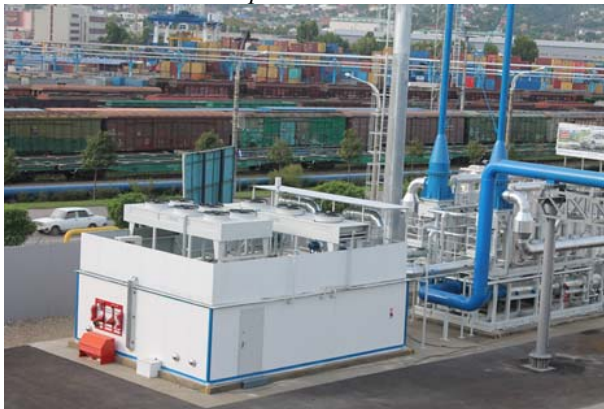
Рис.3. ККР 3000, производительность 3000 м 3 /час. Новороссийск, Новороссийский мазутный терминал. Очистка паровоздушного потока при большом дыхании резервуаров.
