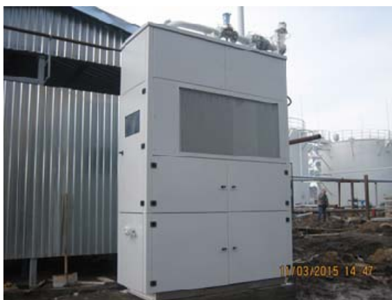
Рис.8. ККР 100М ТУ 3614-001-53976876-2014, номинальная производительность 100 м 3 /час. Иваново, ОАО «Ивхимпром». Рекуперация паров авиационных бензинов.
