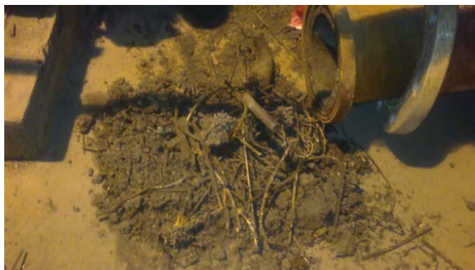
Фото 6. Очистка трубопровода от материала прошедшего через купольный клапан–на исправность клапана не повлияло.
